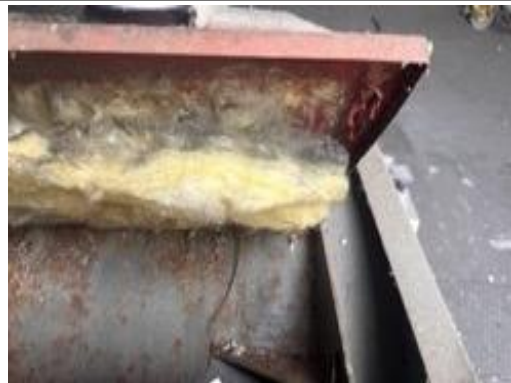
Coibente caldaia
